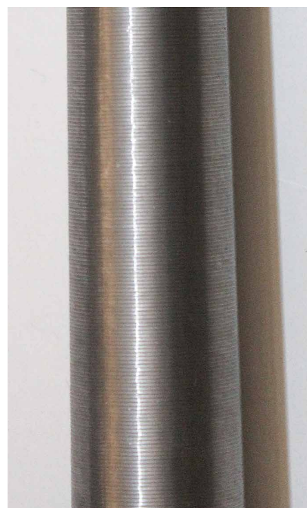
Kiväärin piipussa näkyvät työstöjäljet. Tarkoituksella, sillä eräänä motiivina on piipun jäähdytys.
