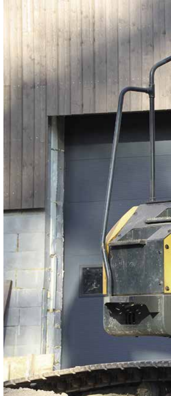
Simo Köylinen tekemässä kaivinkoneellaan töitä
