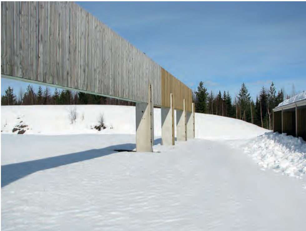
Kuva 9.17. Ampumaradan turvallisuuden parantamiseksi tehty yläkulissi.
