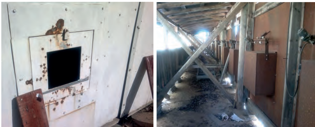
Kuva 5.9. Jurvan luotiloukku edestä ja takaa.
