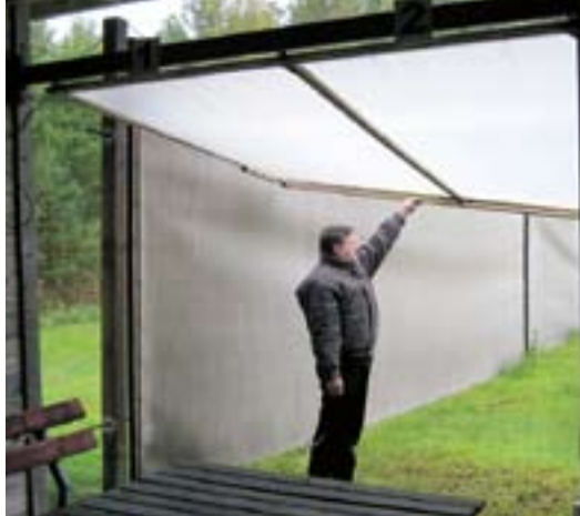
Ampumakatoksen suojaseinämät toimivat kesällä etukulisseina suojaten ampujia auringolta.
