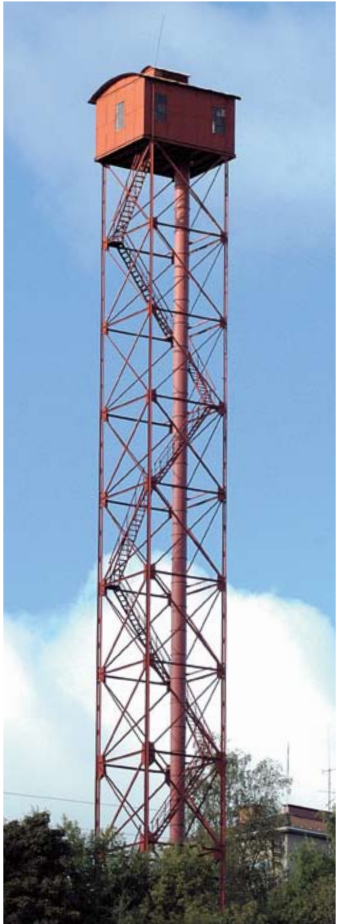
Tampereen haulitorni on tunnettu Pispalan maamerkki.
