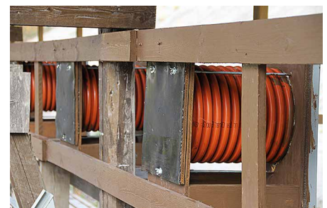
Perusrakenne tehdään Uponorin hulevesiviemärin putkeen. Takastoppina on kahdeksan millimetriä paksu teräslevy.
